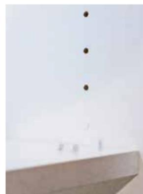
Die Lochreihen werden schon bei der Montage mit farbangepassten Kunststoffstiften verschlossen.
